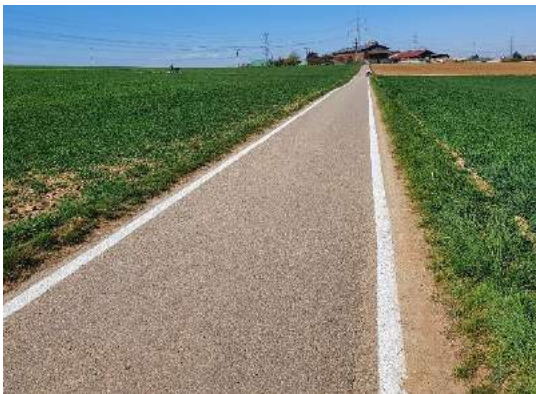
Abb. 36: Retroreflektierende Randmarkierung in Waiblingen, Hohenacker
