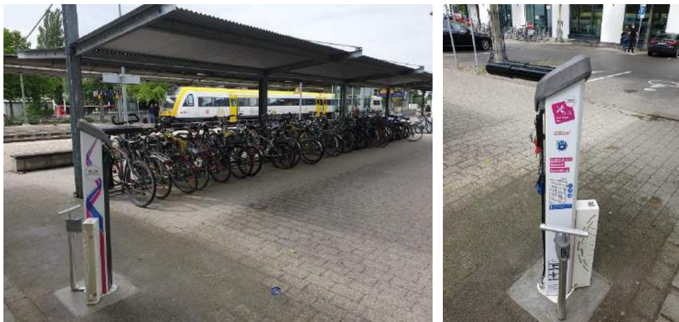
Abb. 47: Radservicestation am Bahnhof Ravensburg
