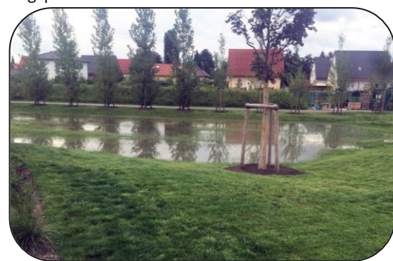
Regenrückhaltefläche (Quelle: StMUV Bayern 2020)
