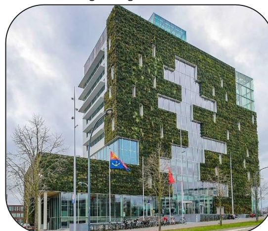
Fassadenbegrünung im Stadskantoor in Venlo (Niederlande) (Quelle: WFMG/Andreas Baum 2019)
