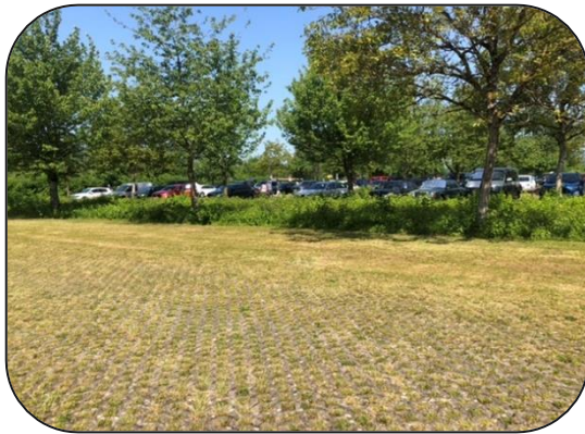
Parkplatz mit wasserdurchlässigem Belag (Quelle: HHP 2023)
