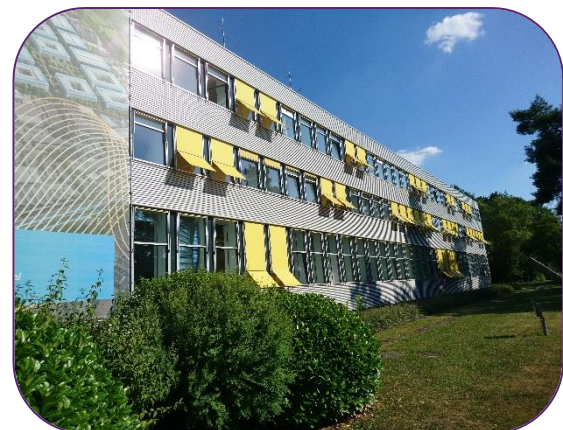
Außenliegender Sonnenschutz an einem Gewerbegebäude in Erlangen (Foto: GEO-NET 2023)
